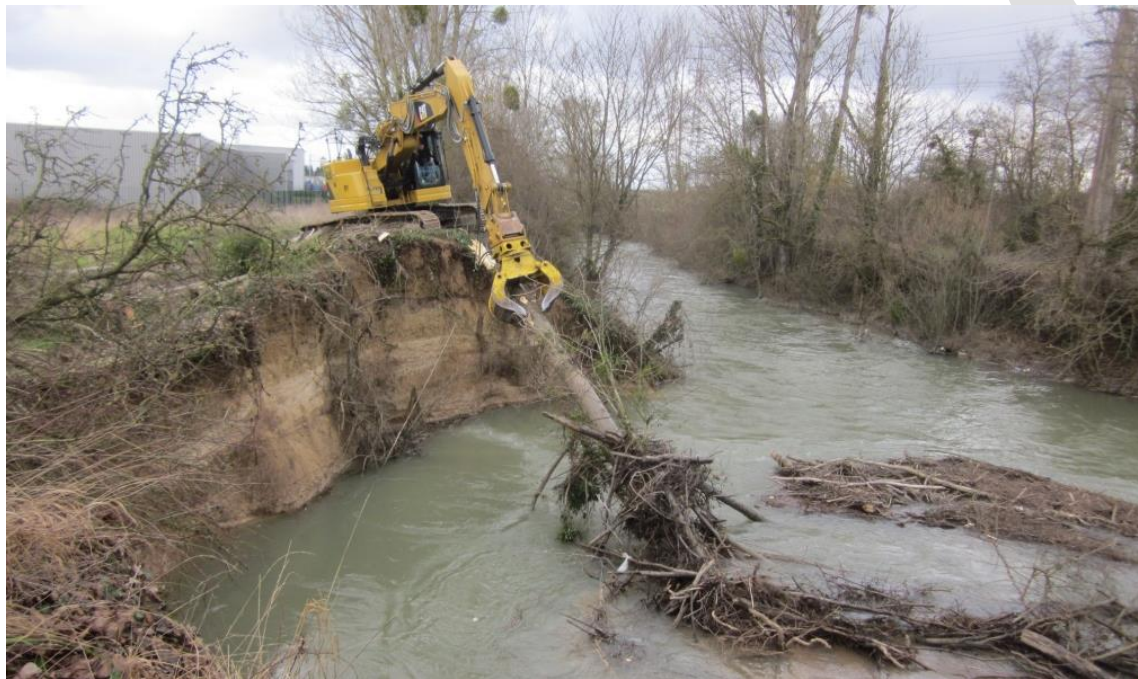
FIGURE 37: TRAVAUX DE RETRAIT D'EMBACLES AU DROIT D'UNE IMPORTANTE EROSION DE BERGE (LA TILLE A GENLIS - 2014)
