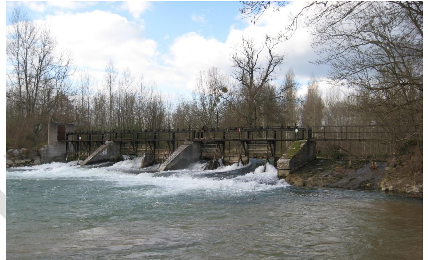
FIGURE 46: BARRAGE DU MOULIN DE CHAMPDOTRE RESTAURE ET EQUIPE EN 2015 POUR LA PRODUCTION D'HYDRAUELECTRICITE
